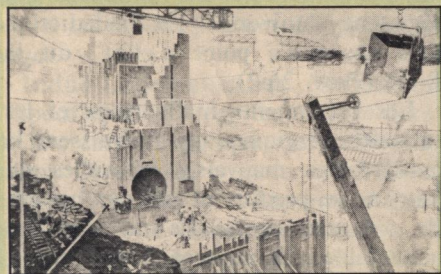
Construction d'une écluse du canal de Panama
